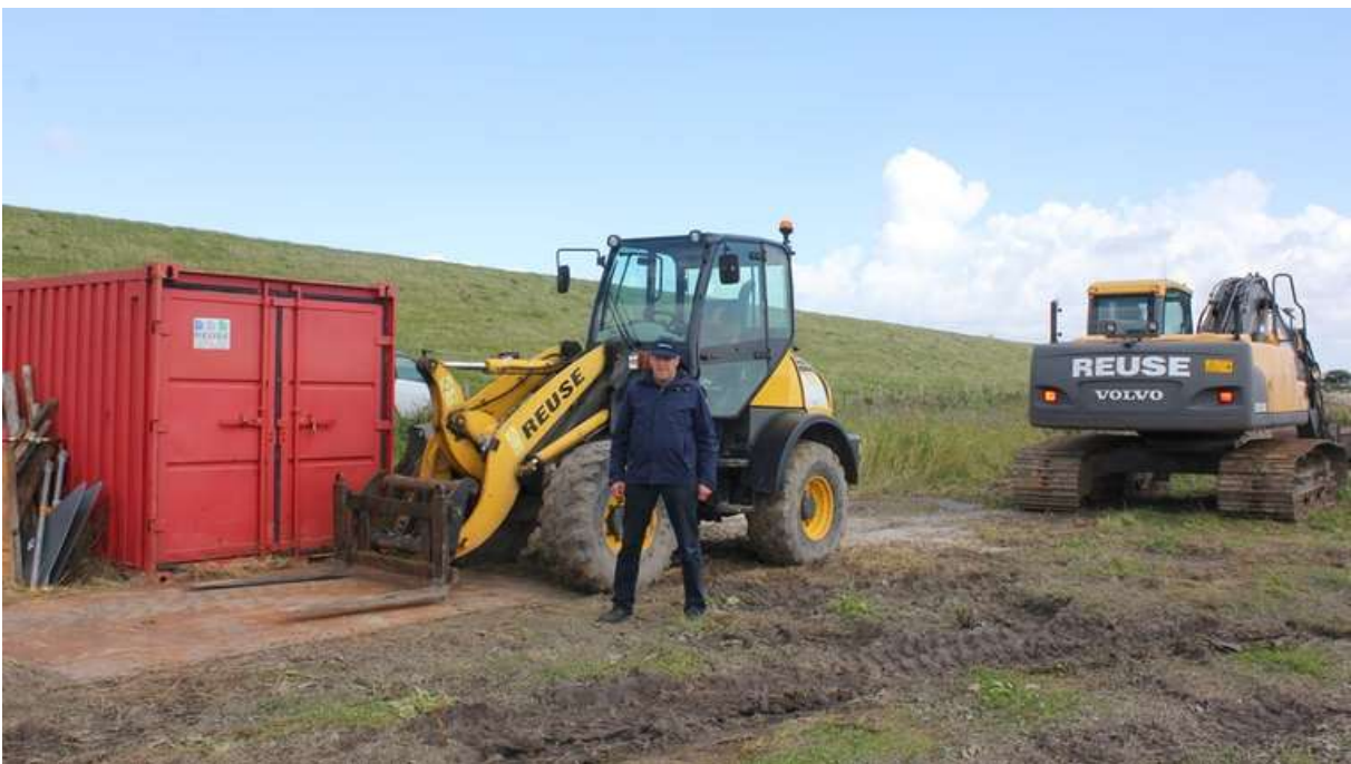
Deichgraf Ernst August Thams ist sauer. Deichbauarbeiten während der Sturmflutssaison seien „ein No-Go seit Hunderten von Jahren“. Starkregen könne den Deich aufweichen
